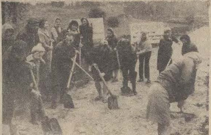
140 członków i kandydatów PZPR oraz bezpartyjnych pracowników wydziału przedziału średniej ZPB Marchewskiego pracowało przy budowie drugiej nitki szosy warszawskiej. Mimo ulewnego deszczu prace przebiegały sprawnie i wydajnie.
