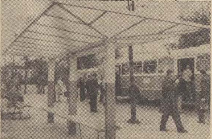
Oto efekt podjętego czynu na Górnej: wiatra dla pasażerów MPK przy pl. Niepodległości. Obok uporządkowano trawniki i chodniki.
