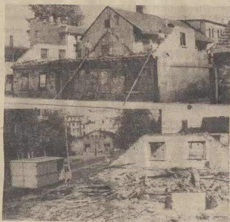
Na ul. Piotrkowskiej w pobliżu ul. Wigury trwa rozbiórka domków łódzkich tkaczy. Tak stara Łódź powoli odchodzi z centrum miasta...
