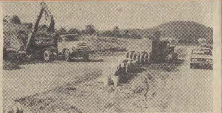
Trwa realizacja jednej z najważniejszych naszych inwestycji drogowych — budowa trasy Kraków — Zakopane. Oddano już odcinek do Myślenic i aktualnie roboty zlokalizowane są na obwodnicy wokół centrum tego miasta i na innych odcinkach trasy. Na zdjęciu: odcinek obwodnicy w budowie. CAF — Piotrowski
