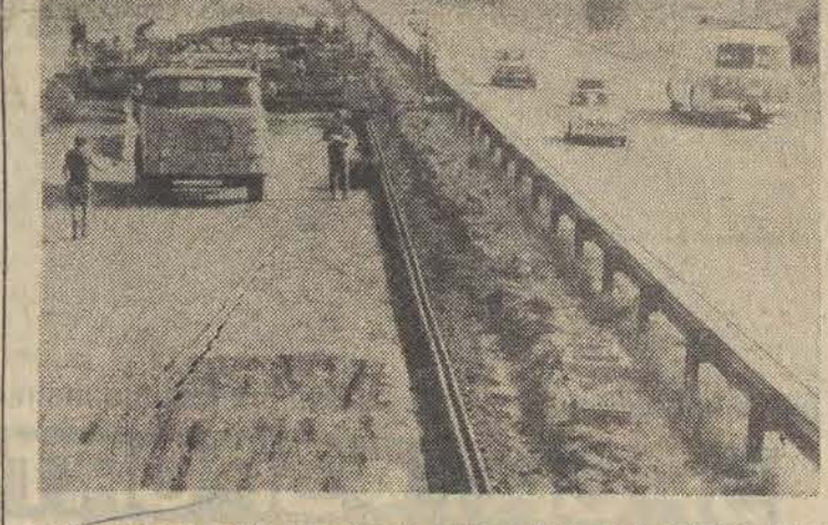
Węgry. Do końca 1975 r. ukończone zostaną prace przy budowie 4-pasmowej autostrady M-7 łączącej Budapeszt z Balatonem. N. z: układanie betonowej nawierzchni na odcinku wylotowym z Budapesztu. CAF — MTI
