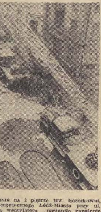
Pożar w „licznikowni”
