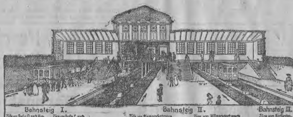
Zentralbahnhof Wittenbergplatz, der zukünftige Knotenpunkt der Berliner Schnellbahnen. Oben: die Einbahnhalle. Unten: die Bahnsteige mit sechs Gleisen. Der bisher zweigleisige Bahnhof wird nach dem Umbau sechs Gleise mit drei getrennten Bahnsteigen aufnehmen und den gesamten Verkehrs der westlichen Schnellbahnen aufnehmen.
