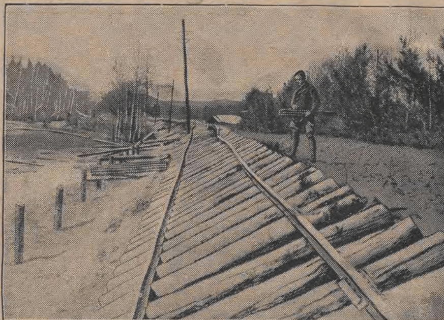
Tor kolejowy zniszczony przez masy lodowe.
