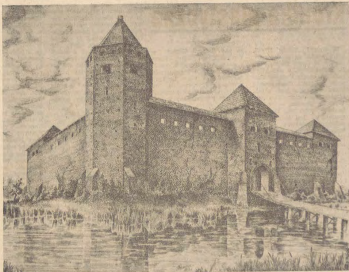
Rawa Mazowiecka — rekonstrukcja zamku
