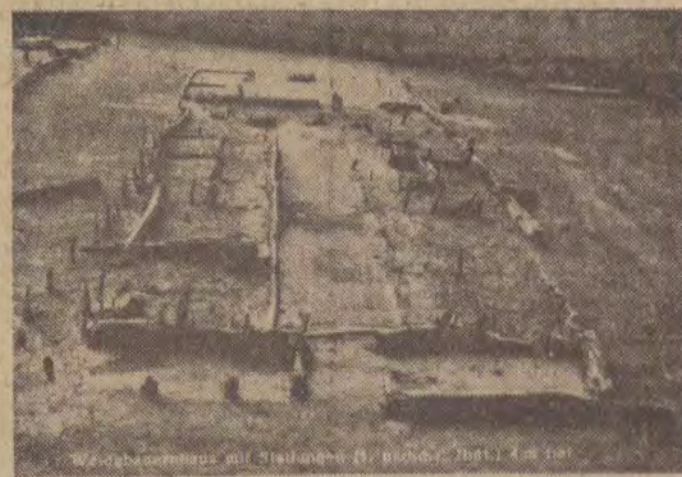
Wykopiska pod Bremerem
