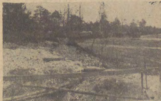
Ogólny widok budowy
