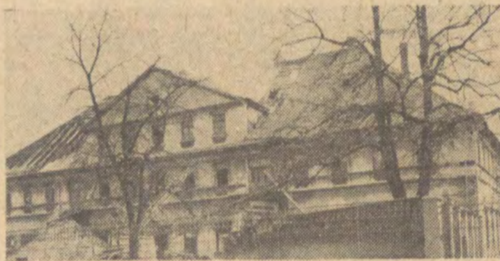
Remont i adaptacja „Bielnika”
