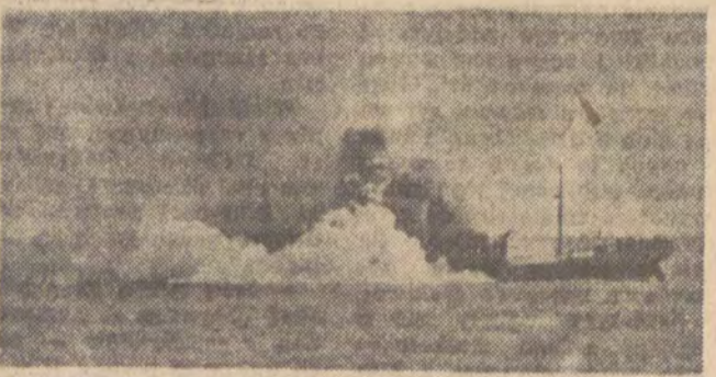
Godz. 7,57 — wybucha kotłownia
