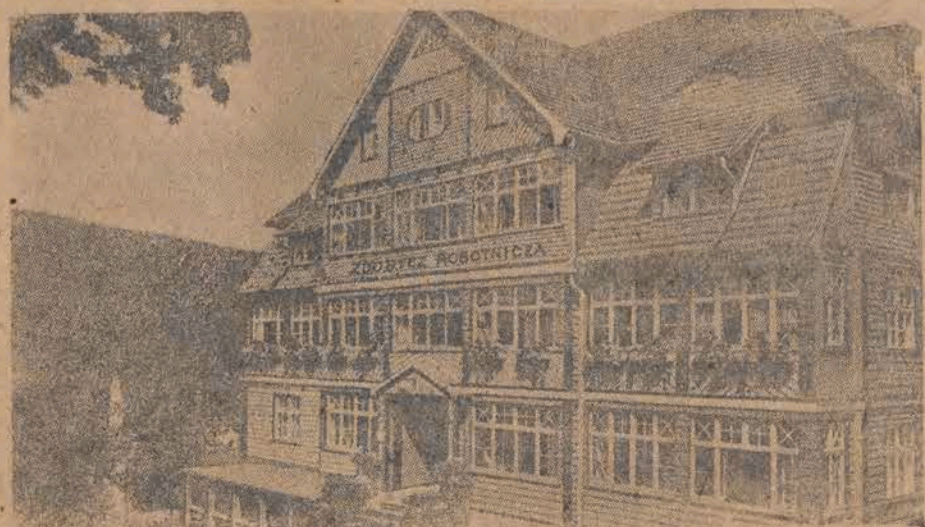
Dom wypoczynkowy dla robotników w Dusznikach — Zdroju „Zdobycz Robotnicza”.
