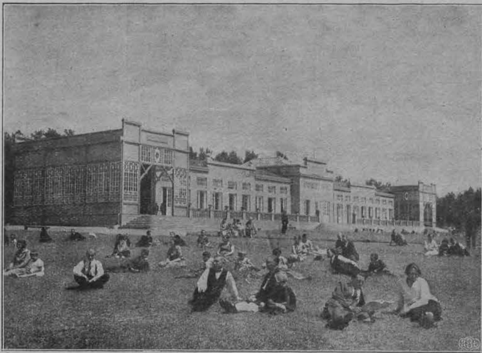
Widok I pawilonu w Tuszyńku.
