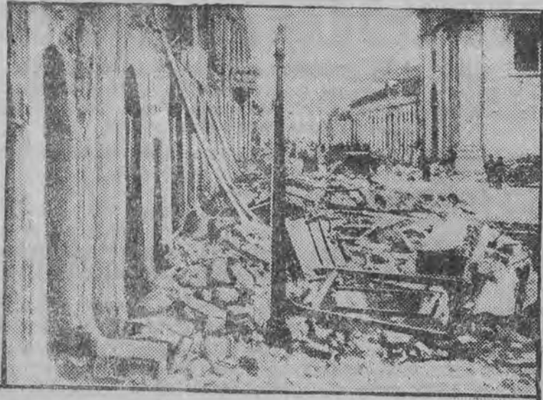
ORYGINALNE ZDJĘCIE TRZĘSIENIA ZIEMI W CHILE
