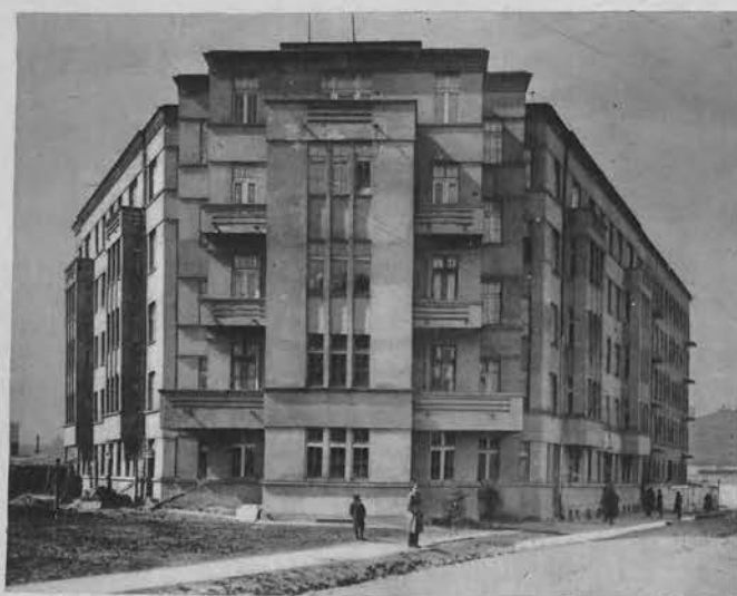
Dom mieszkalny przy ul. Cegielnianej 101.
