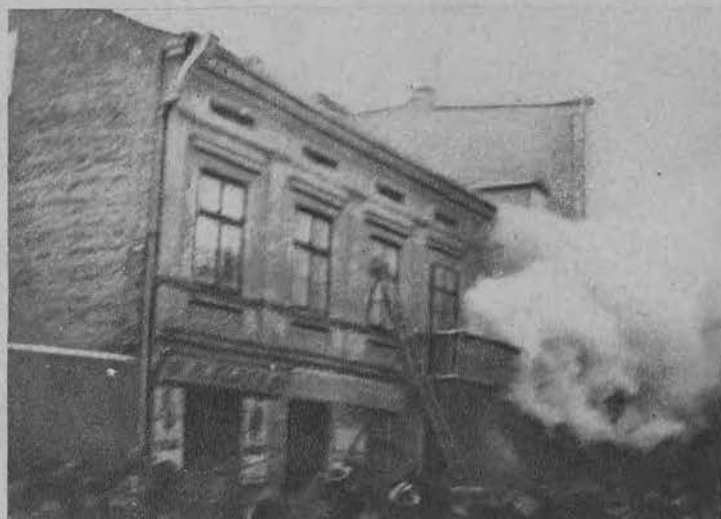
Pali się! Zbiegowisko przed płonącym budynkiem mieszkalnym przy ul. Piłsudskiego 59.
