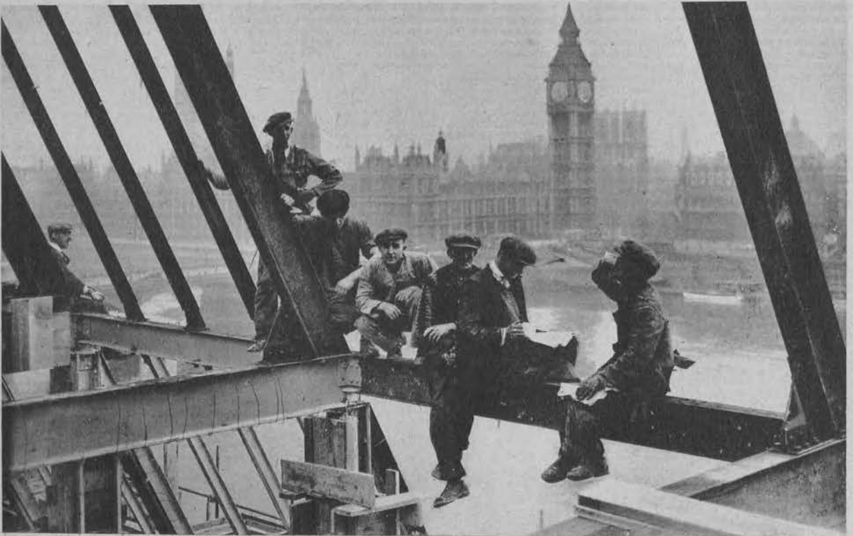
Robotnicy jedzący śniadanie na rusztowaniu budynku na tle Parlamentu w Londynie.
