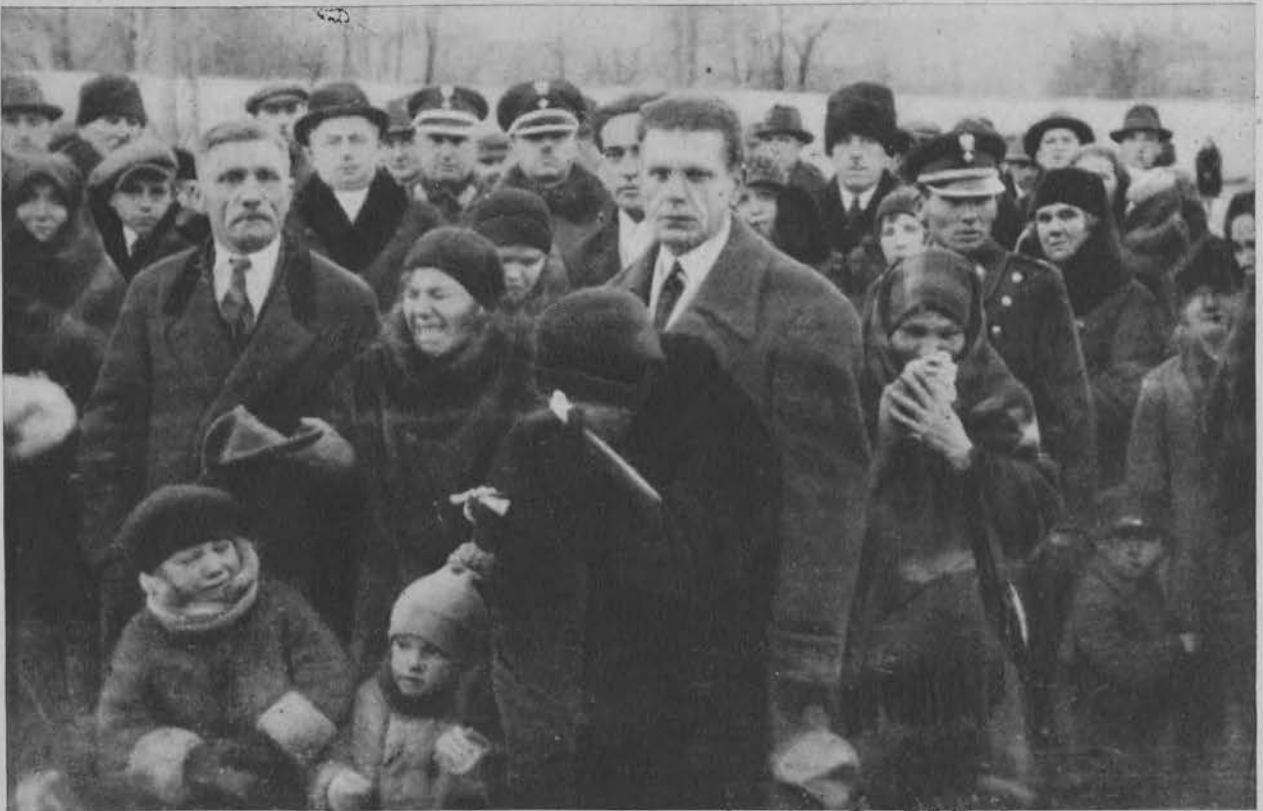
W niedzielę odbył się pogrzeb dzielnego dozorca ś. p. Antoniego Jakowiny, który w pościgu za bandytą, padł od jego kuli. Na zdjęciu widzimy pogrążoną w rozpacz rodzinę zmarłego oraz przedstawicieli władz nad otwartą mogiłą na cmentarzu na Chojnach.
