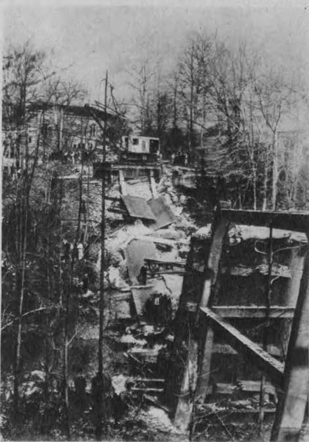
Katastrofa zawalenia się naprawianego mostu betonowego w Takona w Ameryce, który zabił swoim ciężarem 3 robotników, 8 zostało rannych.
