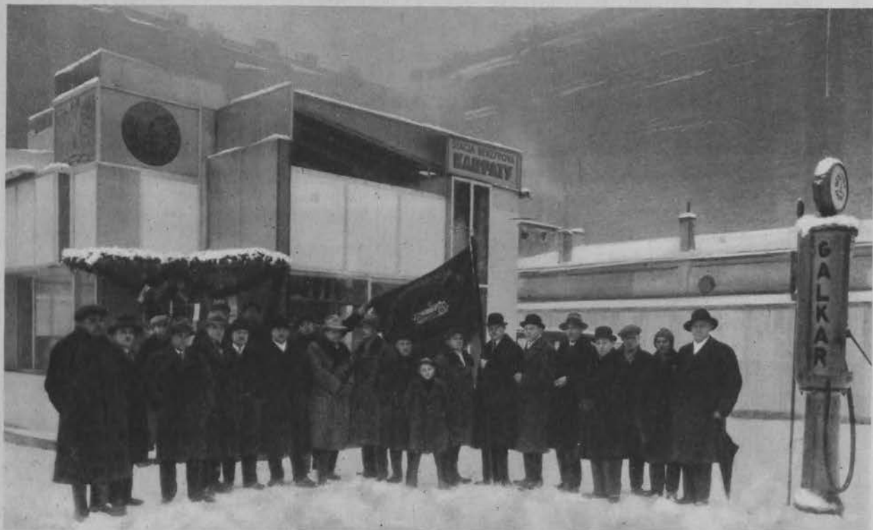
Stacja benzynowa związku zawodowego kierowców samochodowych przy ul. Cegielnianej 2.
