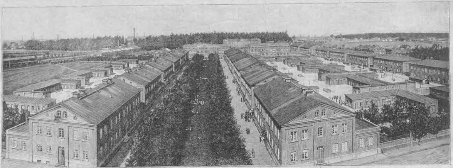
БУМАЖНЫЯ МАНУФАКТУРЫ КАРЛА ШЕЙБЛЕРА. — BAUMWOLL-MANUFACTUR VON CARL SCHEIBLER. 1. Старая фабрика и жилой домъ.— Alte Fabrik und Palais. 2. Домъ Г-на Гербста.— Villa Herbst. 3. Домъ Г-на Шейблера.— Haus Carl Scheibler. 4. Семейные дома. — Arbeiter Familienwohnungen.
