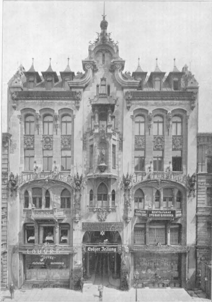
Geschäftshaus der „Lodzjer Zeitung“ Petrikauerstraße Nr. 86.
