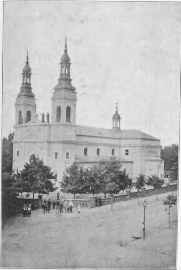
Die neue römisch-katholische Kirche in Tomaszow.
