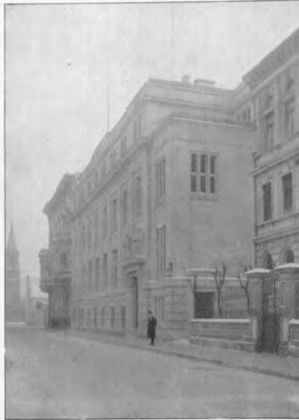
„Gesellschaft Gegenseitigen Kredits Lodzer Industrieller“. Das neue Bankgebäude.
