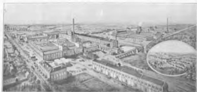
Gesamtansicht der Fabriken der Aktiengesellschaft Heinzl & Kunzler.
