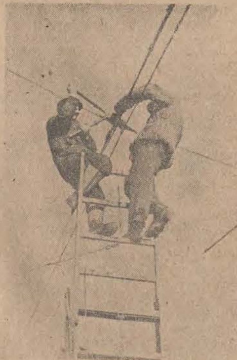
W pajęczynie drutów wysokiego napięcia pracują monterzy tramwajowi
