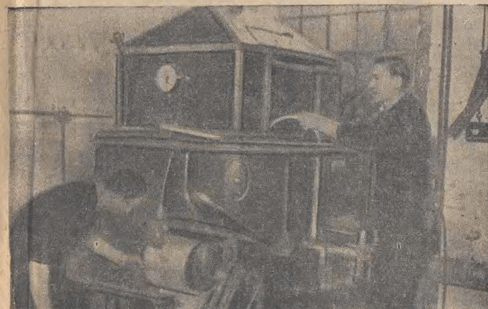
Tow. tow. Stefan Tomaszewski i Leszek Krygler odlewają płytę w automatycznym aparacie.
