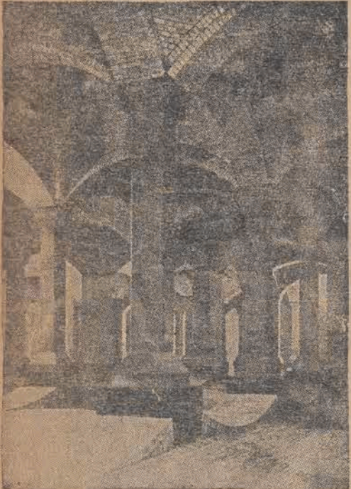
Zbiornik wody czystej na Siokach
