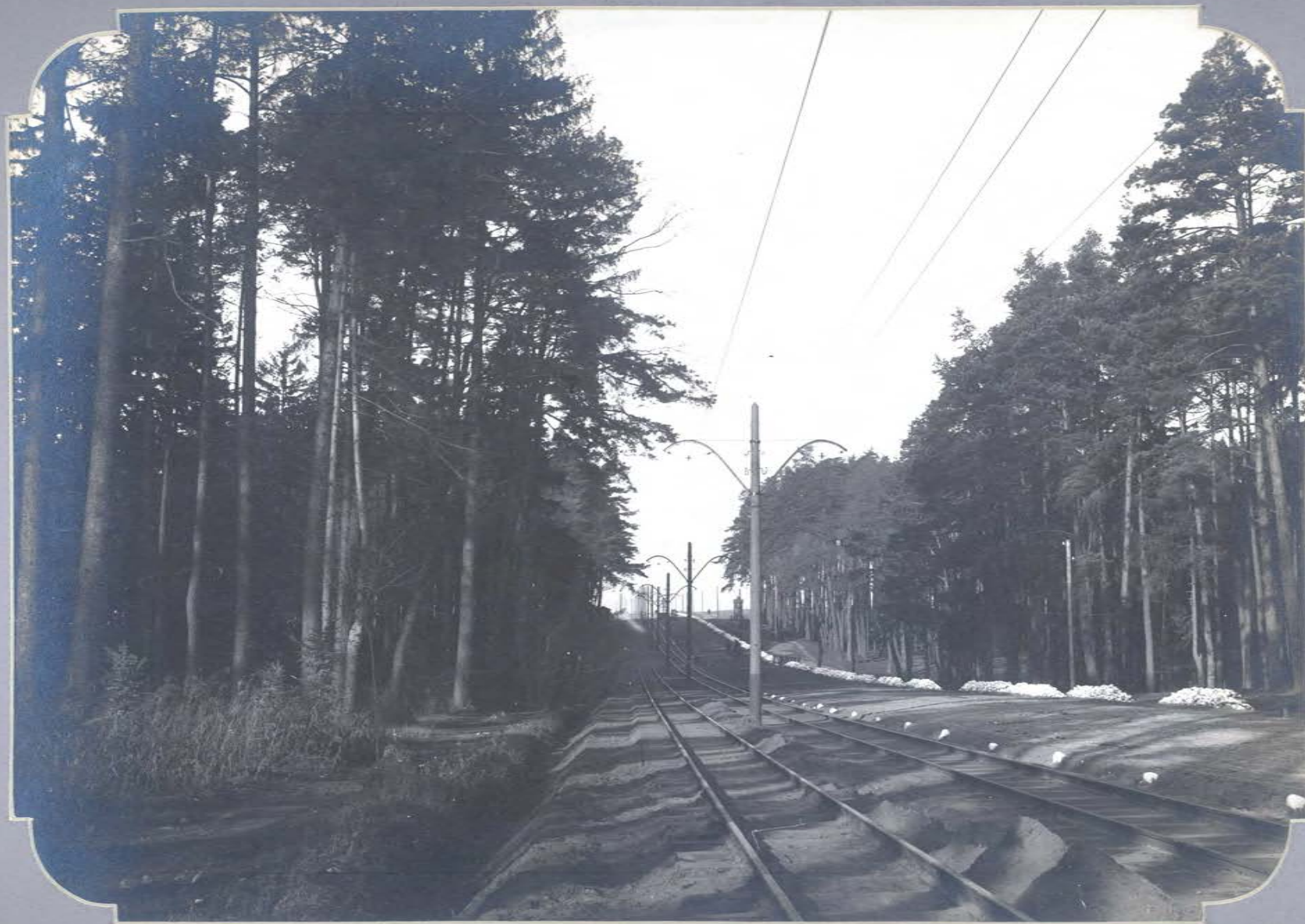
Widok linii Łódź-Zgierz na wior. 6.
