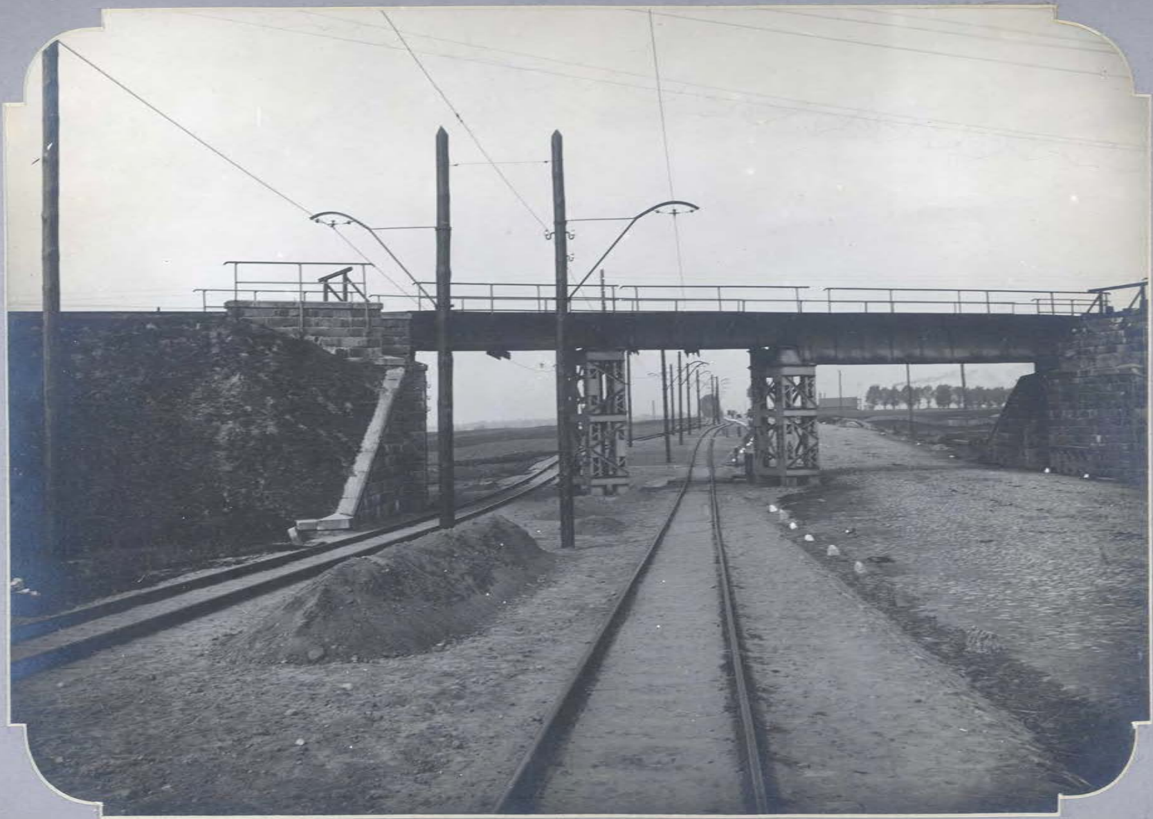
Widok linii Łódź-Zgierz na wior. 7 (wiadukt dr. ż. W. K.).
