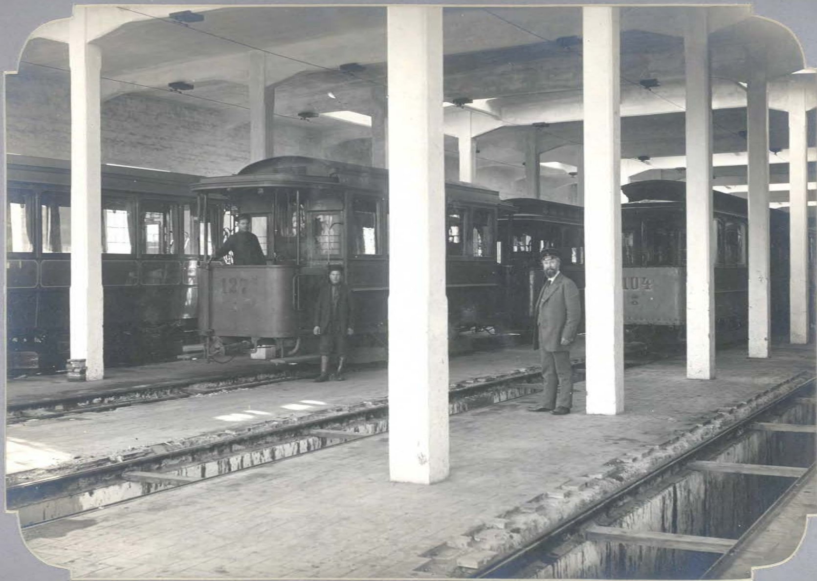
Widok wewnętrzny remizy na stacji centralnej linii Łódź-Zgierz.
