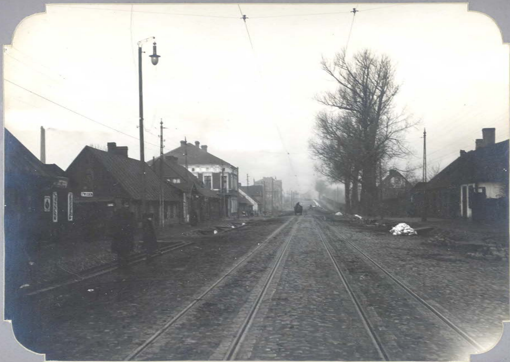
Widok linii Łódź-Zgierz na wior. 2.
