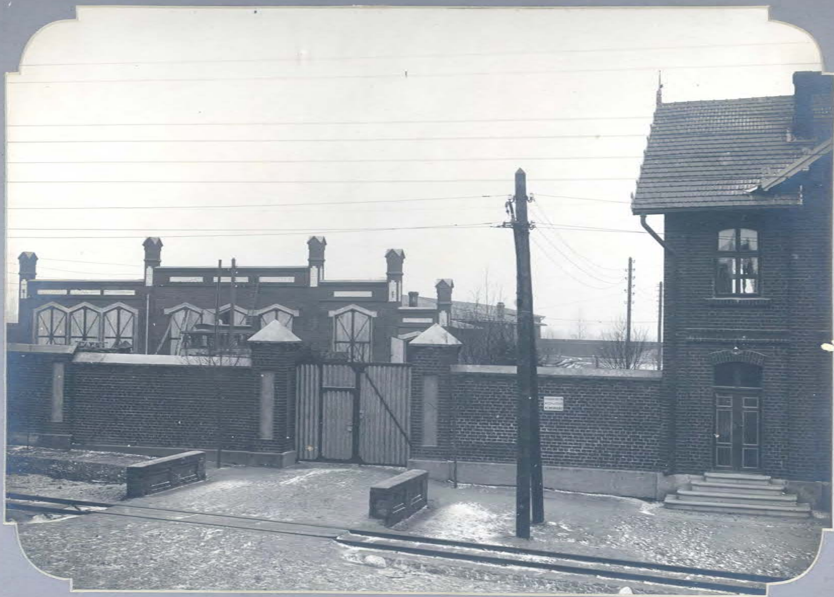
Widok remizy na stacji centralnej linii Łódź-Pabjanice.
