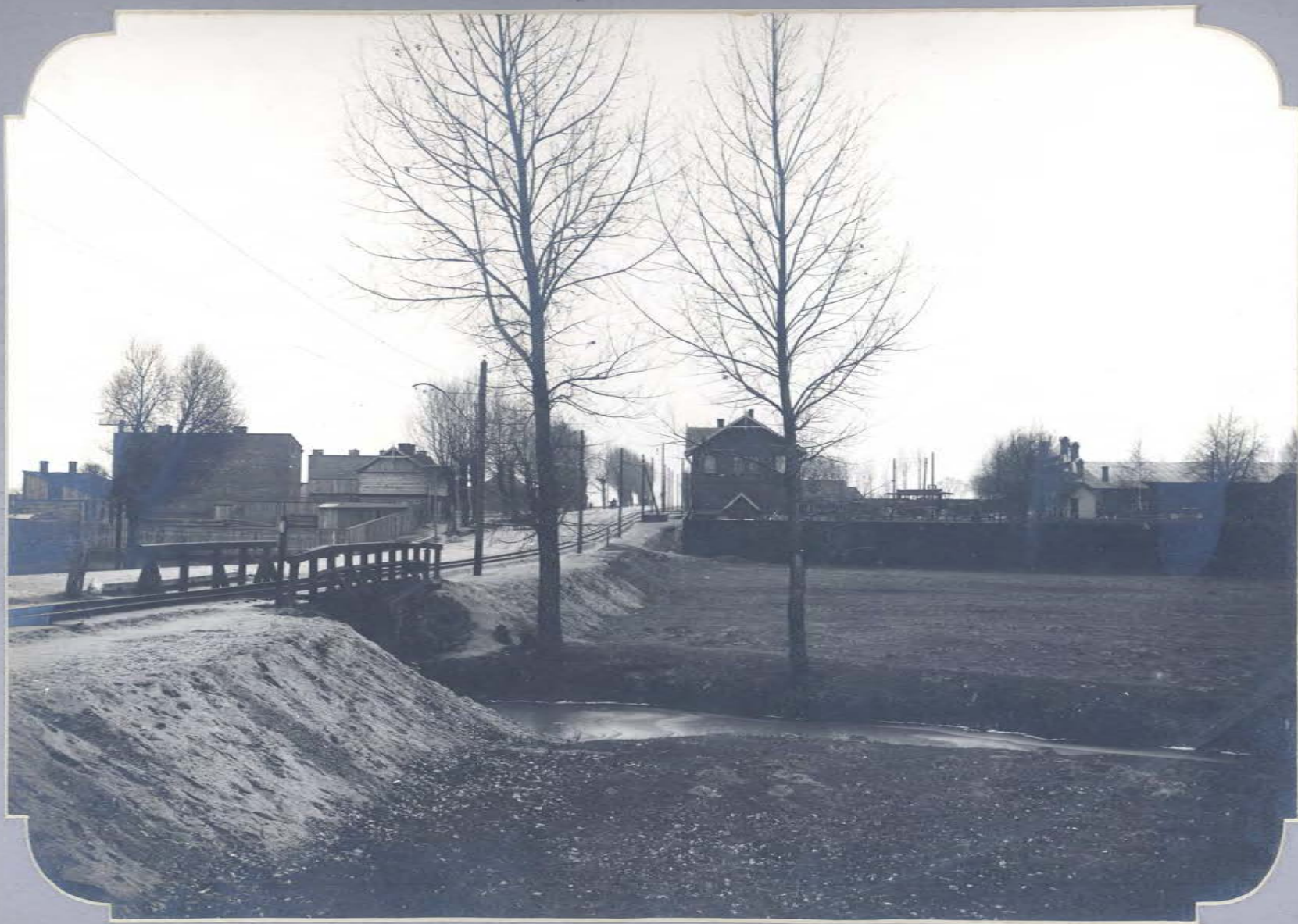
Widok linii Łódź-Pabjanice na wior. 4 (Most na rzece Ner).
