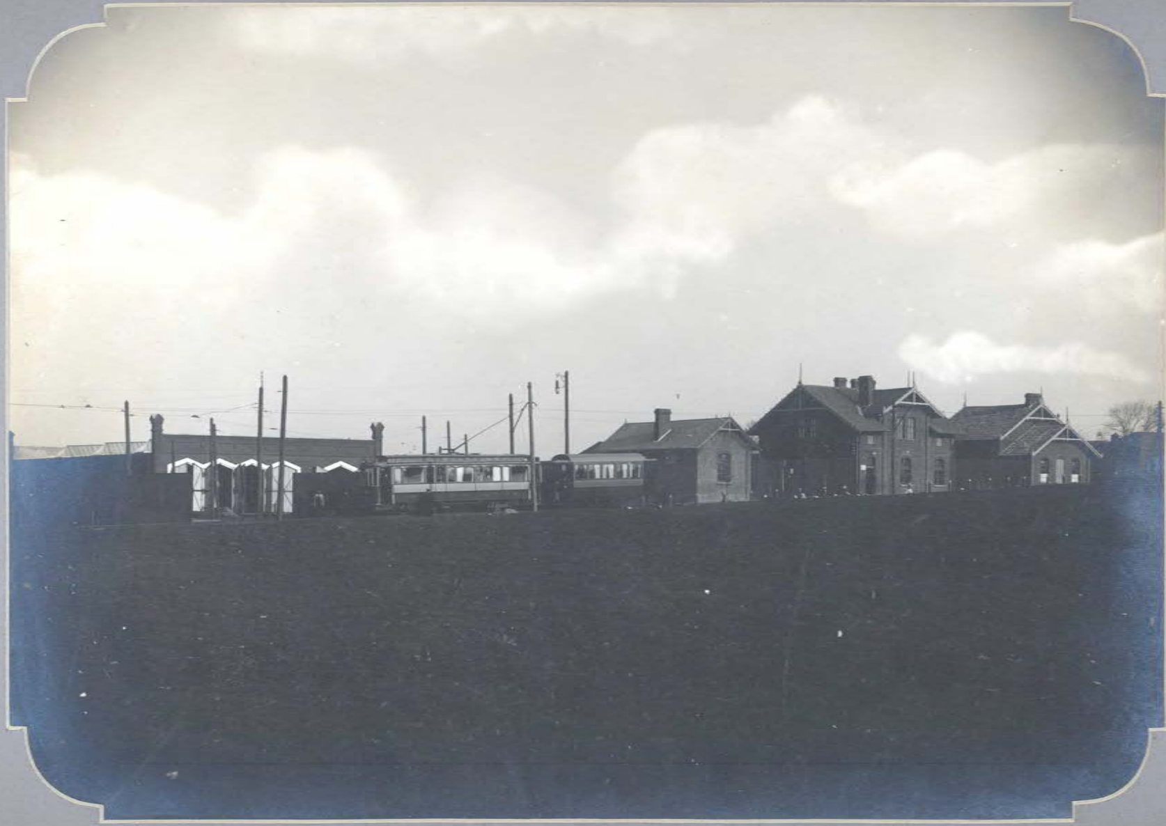
Widok ogólny stacji centralnej na linii Łódź-Konstantynów.
