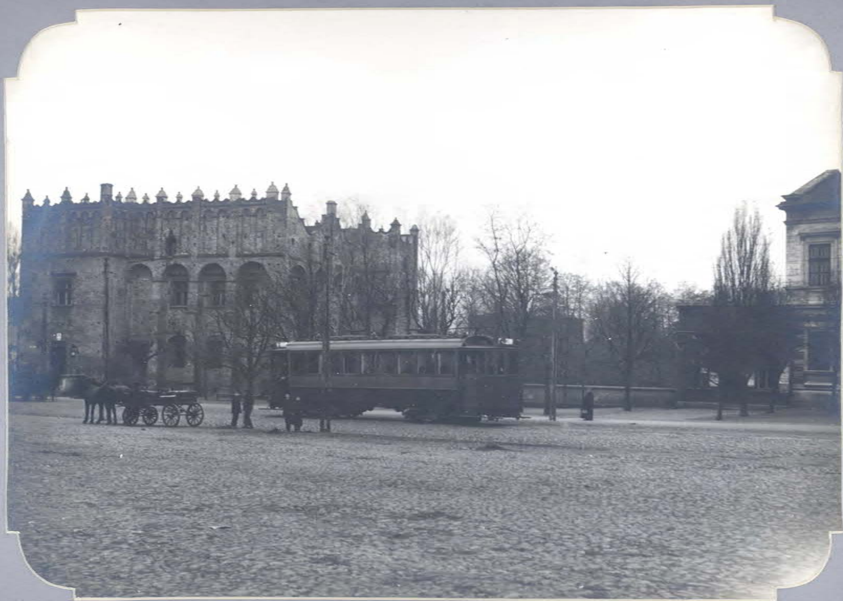
Krańcowy punkt linii Łódź-Pabjanice w m. Pabjanicach.
