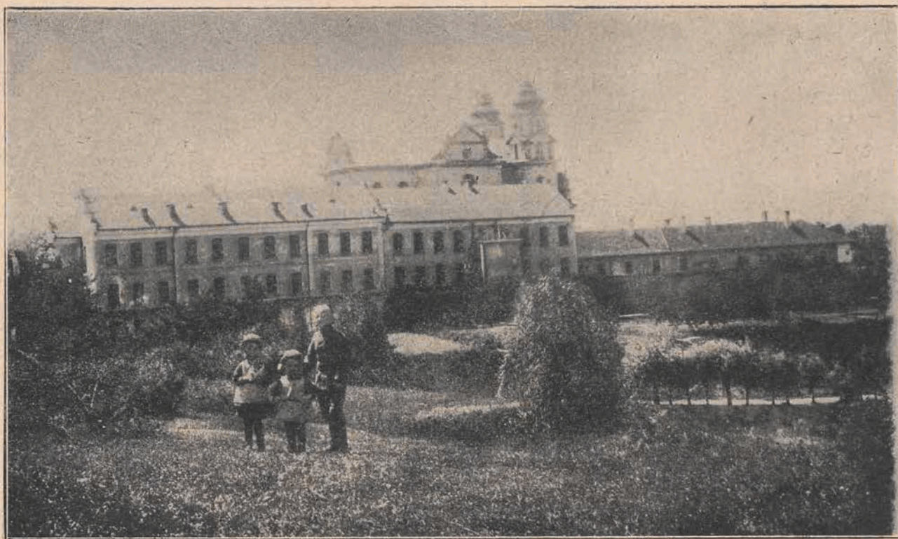
Zewnętrzny widok więzienia w Wiśniczu.
