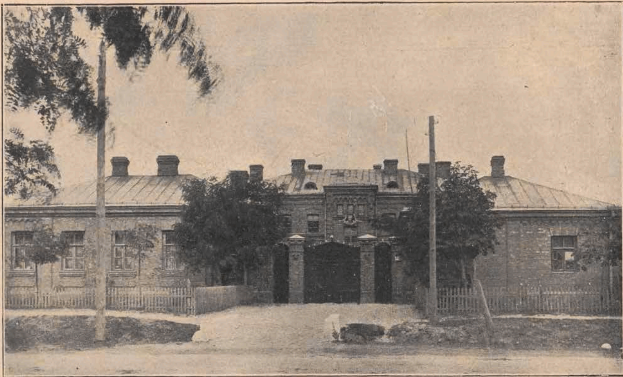
Widok frontowy więzienia w Ostrołęce.
