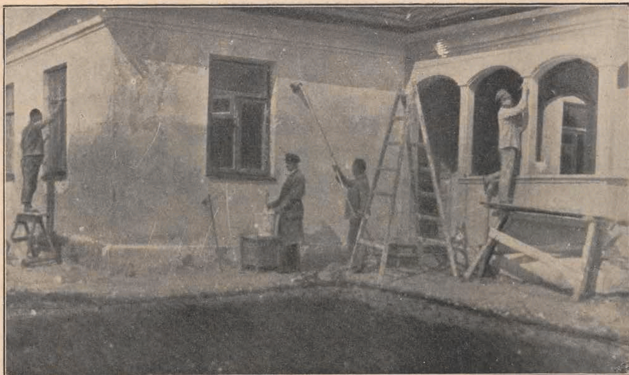
Zakład wychowawczo-poprawczy w Wielucianach. Roboty murarskie wychowanków.
