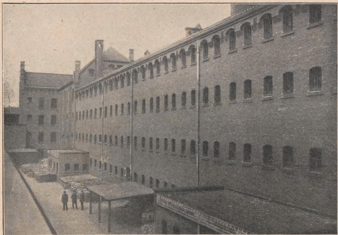
Wewnętrzny widok więzienia w Mysłowicach.
