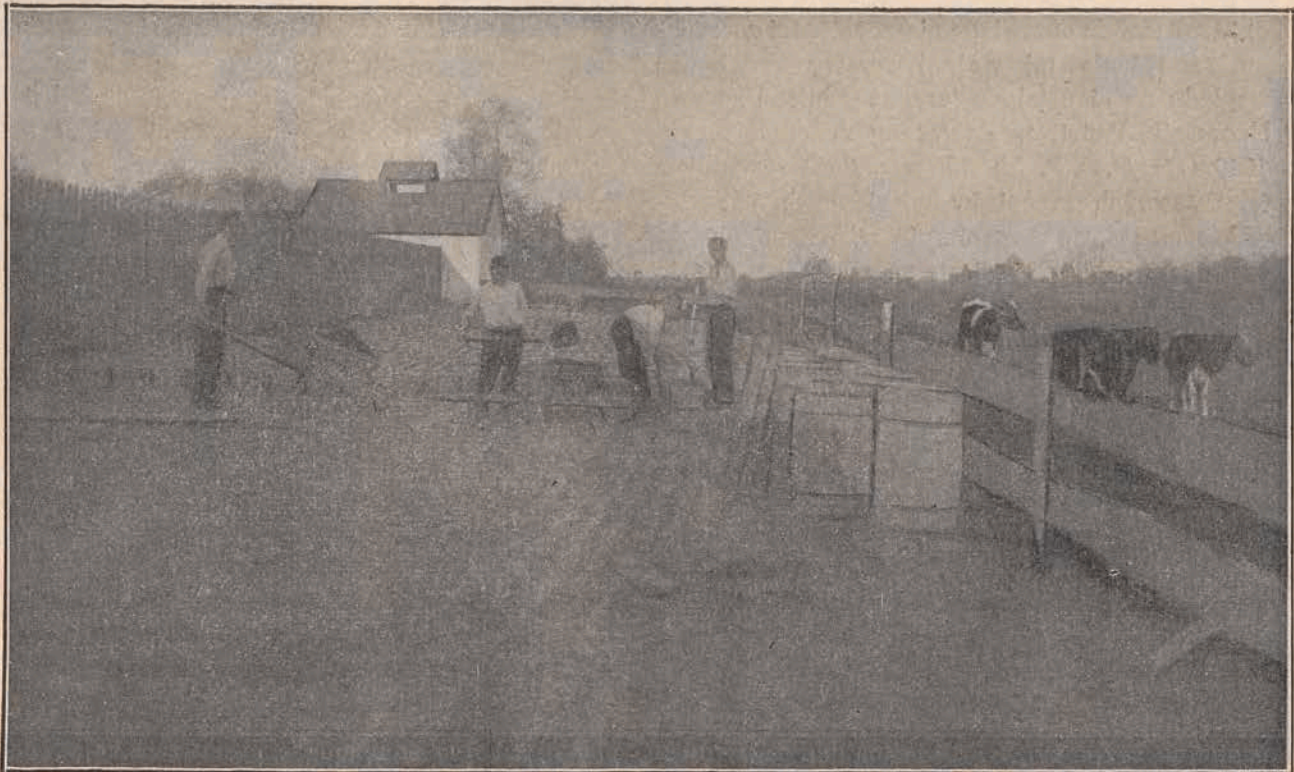
Zakład wychowawczo-poprawczy w Głazie. Betoniarnia.
