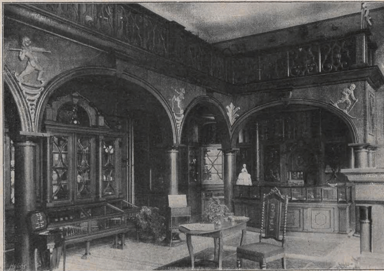
WNĘTRZE NOWEGO MAGAZYNU T-WA KOMISPOL
