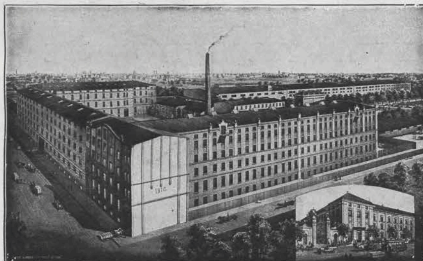
Ogólny widok fabryki
