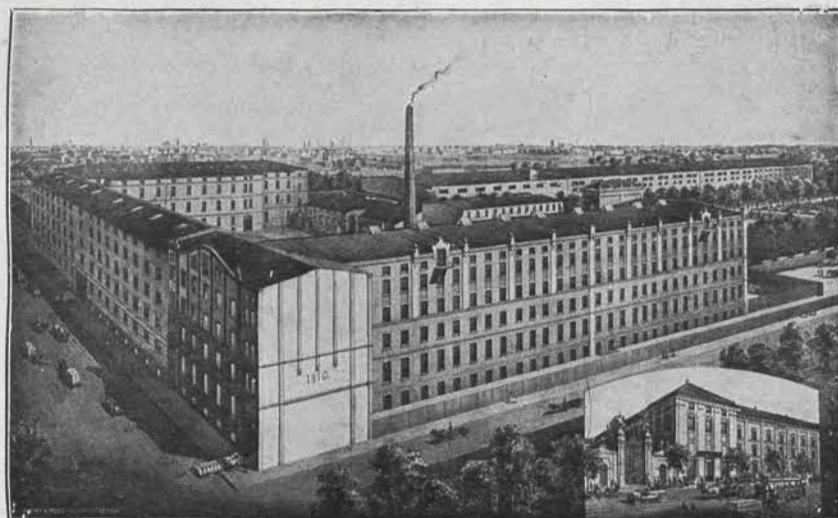
Ogólny widok fabryki
