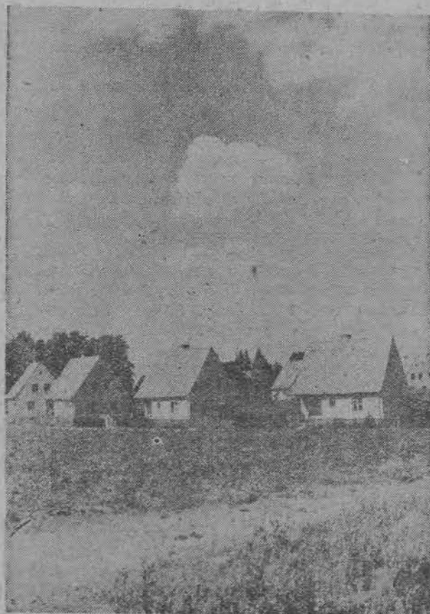
Pracowite ręce polskiego rolnika i robotnika usu- wają ślady zniszczenia wywołane działaniami wojennymi na Ziemiach Odzyskanych. Na ilustracji wzorowe zabudowania osadników rolnych w powie- cie Świdnickim na Dolnym Śląsku.
