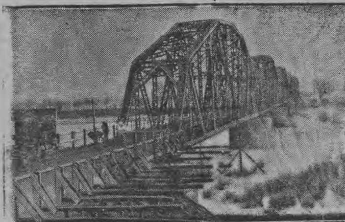
Most kolejowy na wiśle pod Sandomierzem.
