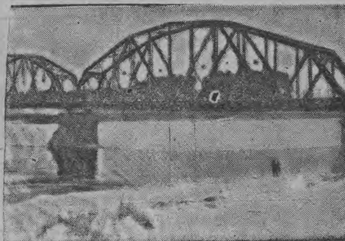
Ten sam most w czasie próby wytrzymałości przęsła.
