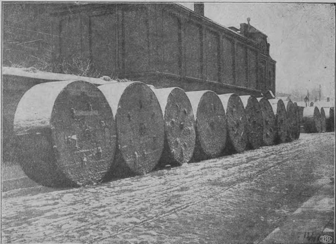
Kable ziemne o napięciu 35 tys. volt, przeznaczone dla zasilenia Pabjanic prądem Elektrowni Łódzkiej.
