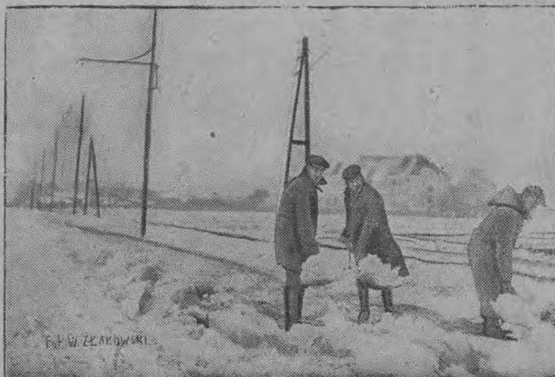
Uprzątnięcie śniegu z torów kolejowych.
