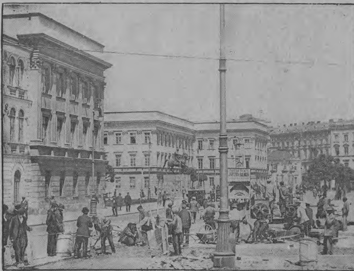
Budowa jezdni asfaltowej na ul. Królewskiej, od pl. Małachowskiego do Krak.-Przedmieścia.
