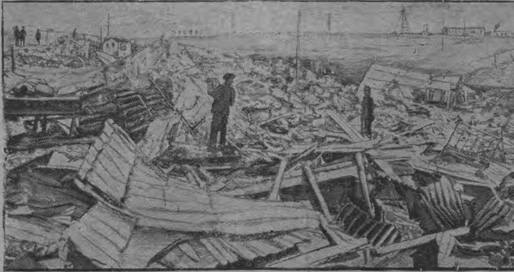
Oto co pozostało po forte w Melilli, po wybuchu znajdujących się w nim magazynów amunicyjnych.
