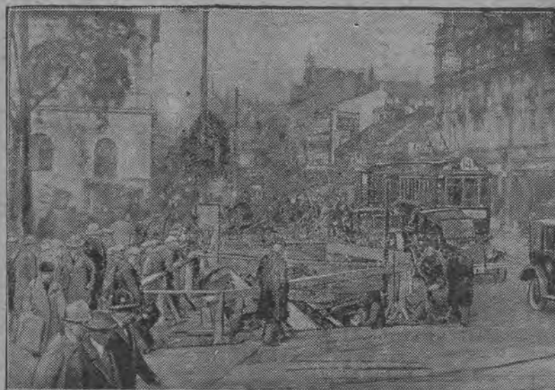
Roboty przy budowie konstrukcji odciążającej pod ul. Marszałkowską.
