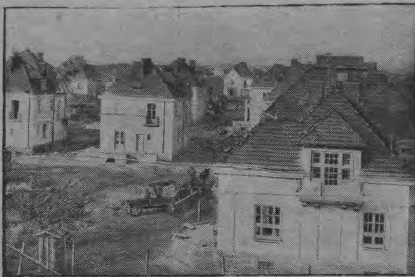
W Mokotowie dźwiga się nowa, nowoczesna dzielnica „Henryków” z której ukazujemy obrazek radujący oczy nie tylko warszawian. Jeszcze dwa lata tego tempa prac a klęska mieszkaniowa stanie się w stolicy zamierzczłym koszmarem.
