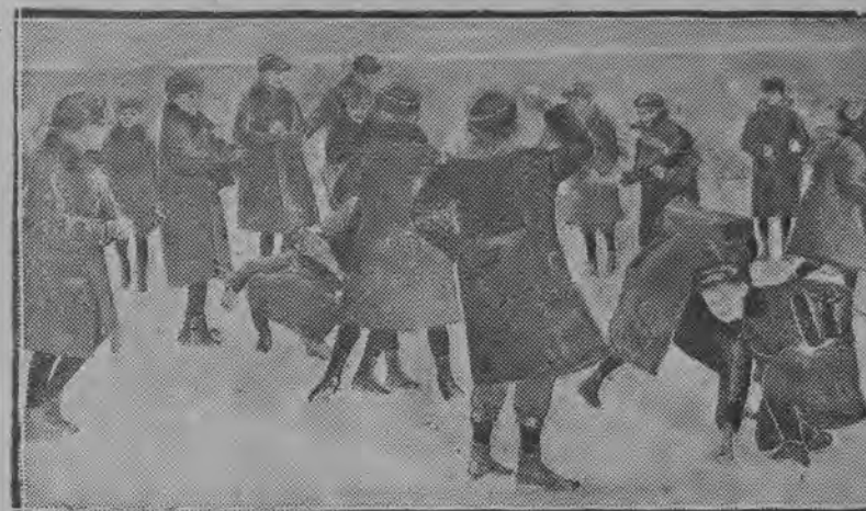
Ślizgawka na placu Stow. „Union” przy ul. Przejazd.
