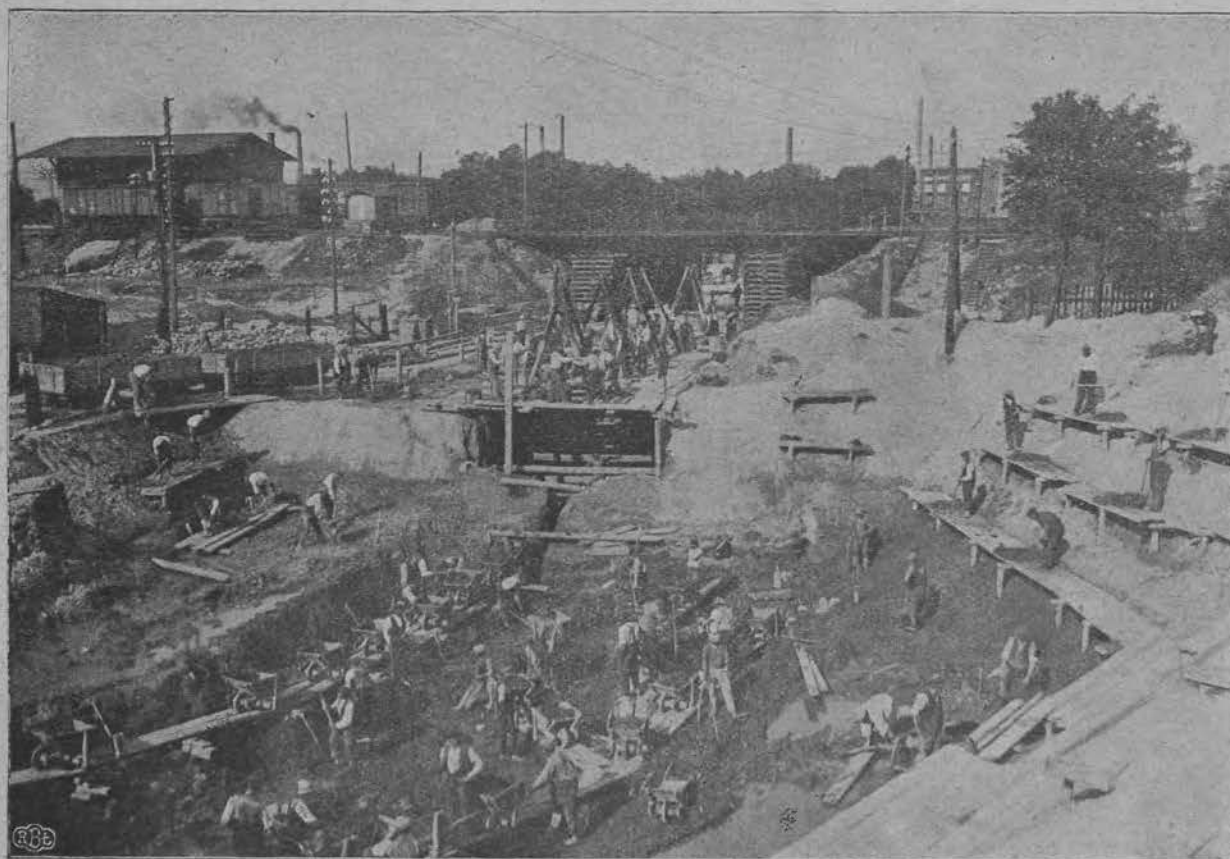
Prace nad połączeniem kolektora z burzowcem przy ulicy Karolewskiej.
