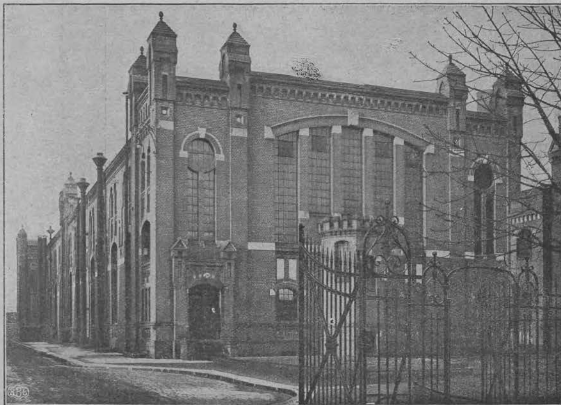
Ogólny widok maszynowni przy ul. Targowej 1.
