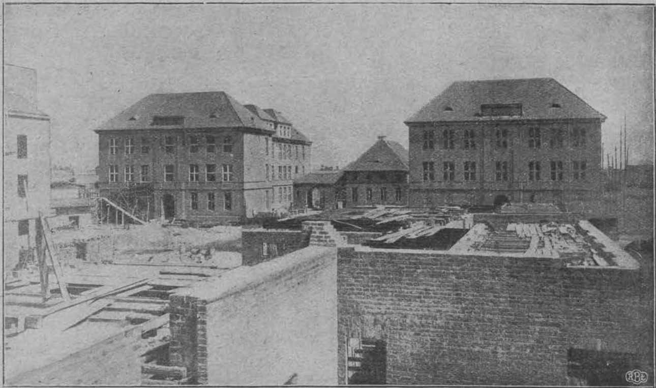
Widok gmachu szkolnego przy ul. Podmiejskiej. Na pierwszym planie budujący się dom mieszkalny dla nauczycielstwa.
