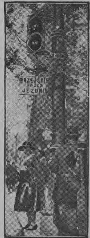
Skrzynka sygnalna na ulicach Warszawy.
