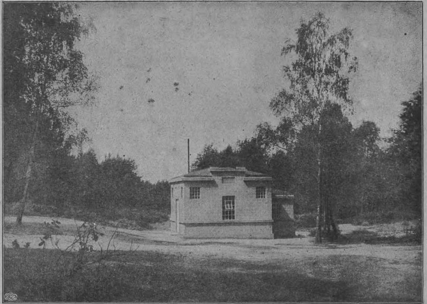
Elektrownia przy Sanatorjum w Tuszyńku.
