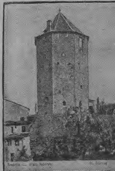
Brodnica nad Drwęcą Wieża Mazurska
