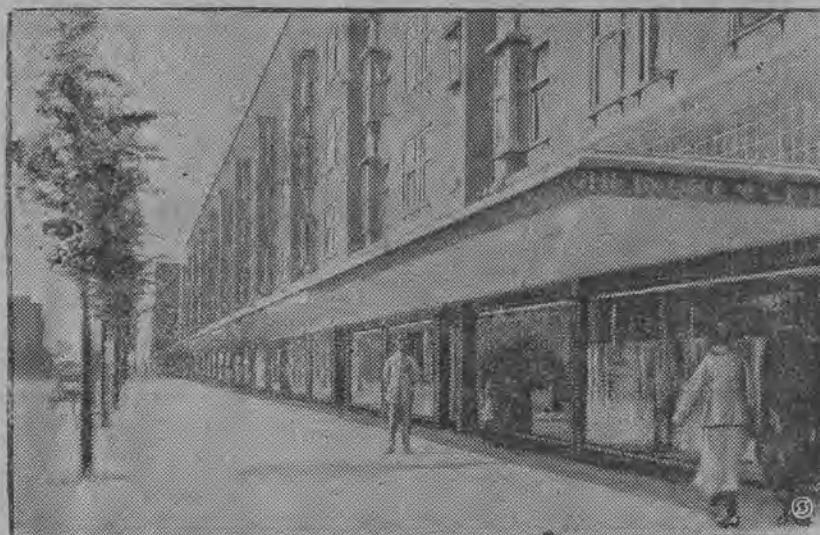
ze szklanym dachem wzdłuż chodnika, chroniącym przechodniów od deszczu.
