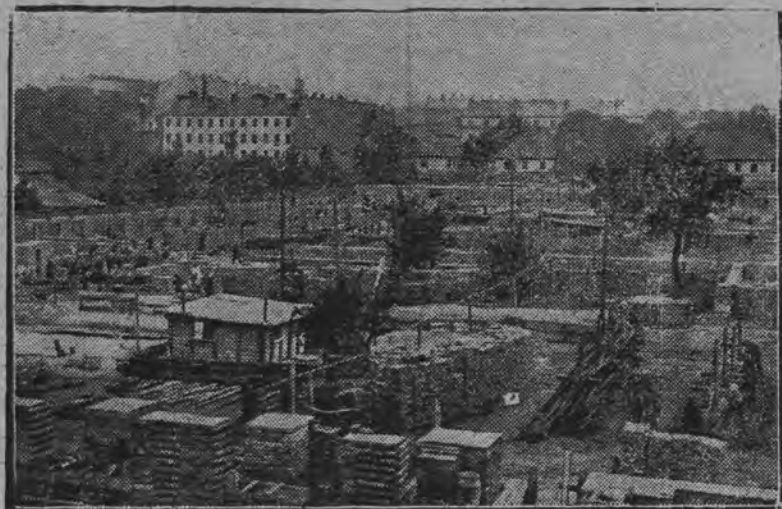
Fragment z budowy imponującego gmachu.
