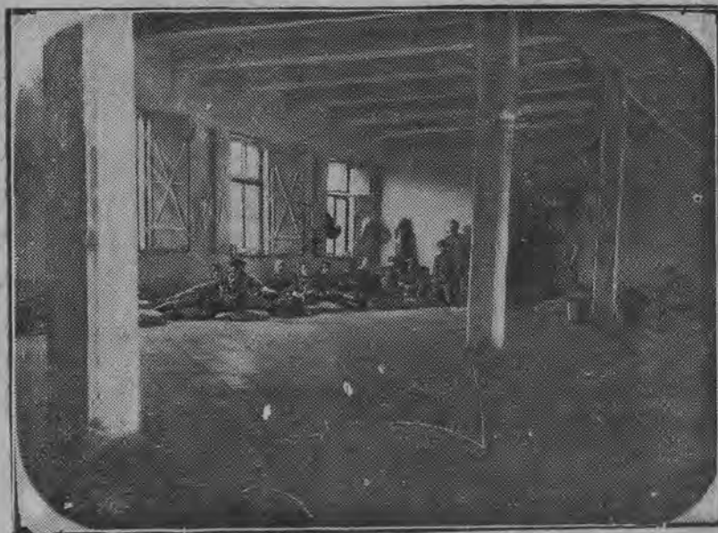
Więzienie austriackie w Przemyślu, gdzie przebywali oficerowie legionowi.
