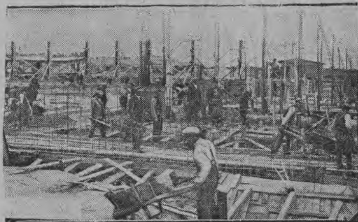
Budowa europejskiego lotniska i hangarów na Okęciu pod Warszawą.
