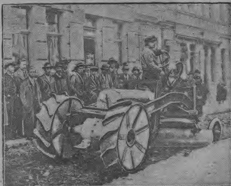
Maszyna do układania bruków ulicznych jest najnowszym wynalazkiem w gospodarce komunalnej i zastępuje dziesiątki rąk roboczych.
