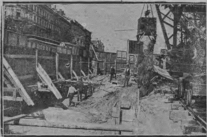
Budowa wielkich osadników na Czerniakowie.
