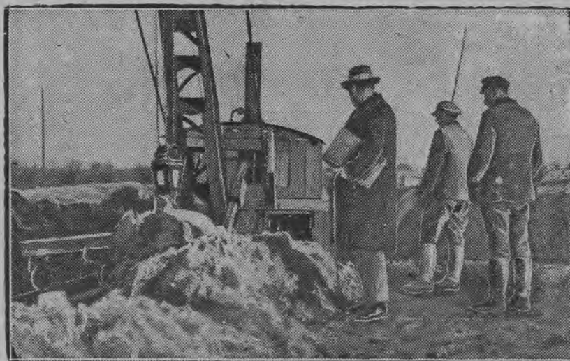
Draga pracująca przy budowie osadników.
