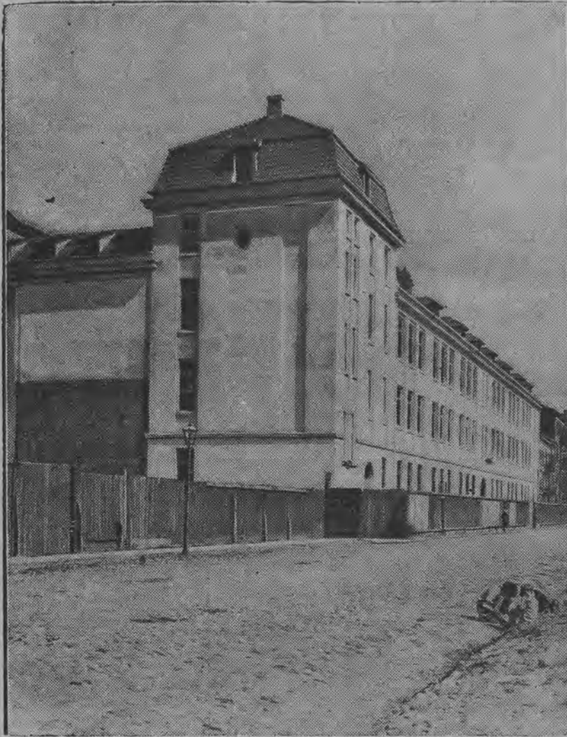
Piękny gmach pożytecznej szkoły zawodowej powstaje przy ulicy Hożej w Warszawie.
