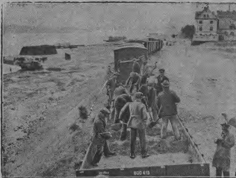
Budowa wielkiego parku Traugutta na stokach dwóch fortów b. Cytadeli warszawskiej.
