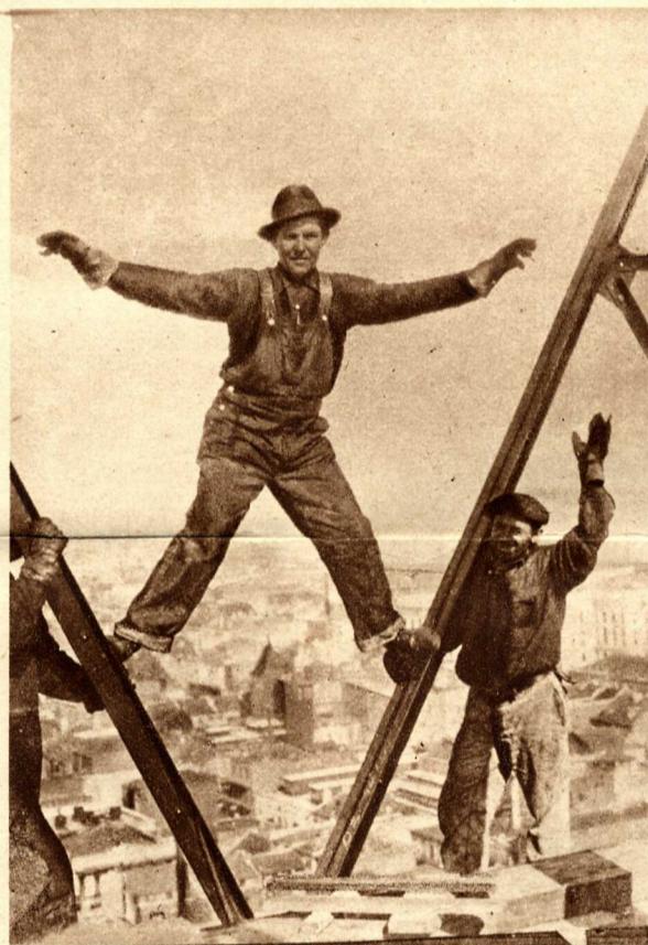
Człowiek bez nerwów. Jak bardzo przyzwyczać się można do niebezpieczeństwa, wskazuje fotografia trzech robotników na amerykańskim drapaczu chmur, którzy nie kontentują się swoim powietrznym zawodem, ale jeszcze wykonują szczególne sztuki na rusztowaniu żelaznym na wysokości 50 m.
